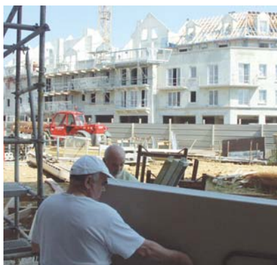
Hôtel de Ville : les travaux d'aménagement intérieurs ont débuté avec notamment la pose des cloisons...
